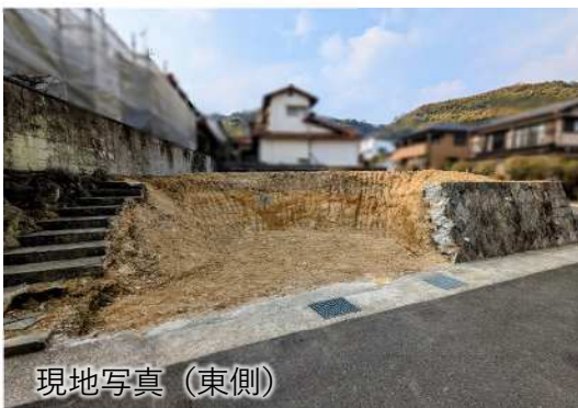
現地写真（北東側）
