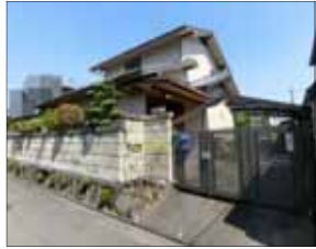
現地外観写真
